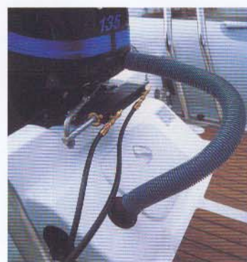
Sådan skal det se ud. Kabler og slanger ligger i en vandtæt slange.
